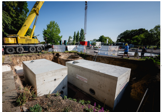
Setzen von Zisterne und Pumpenstube
